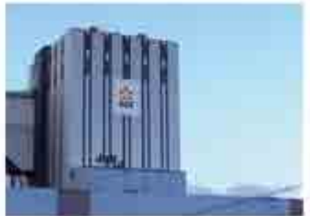
La chaudière vue de l'extérieur
