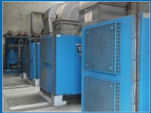
Cabine peinture préchauffée par chaleur récupérée sur compresseurs
