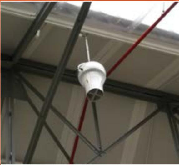
Les destratificateurs renvoient l'air surchauffé accumulé au plafond vers le sol.
