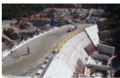
INSTALLATION OPTIQUE À RIZZANESE
