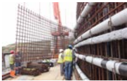
INSTALLATION OPTIQUE EXPÉRIMENTALE DE L'EPR FLAMANVILLE 3
