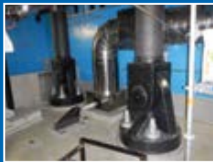
L'étanchéité et des ancrages
