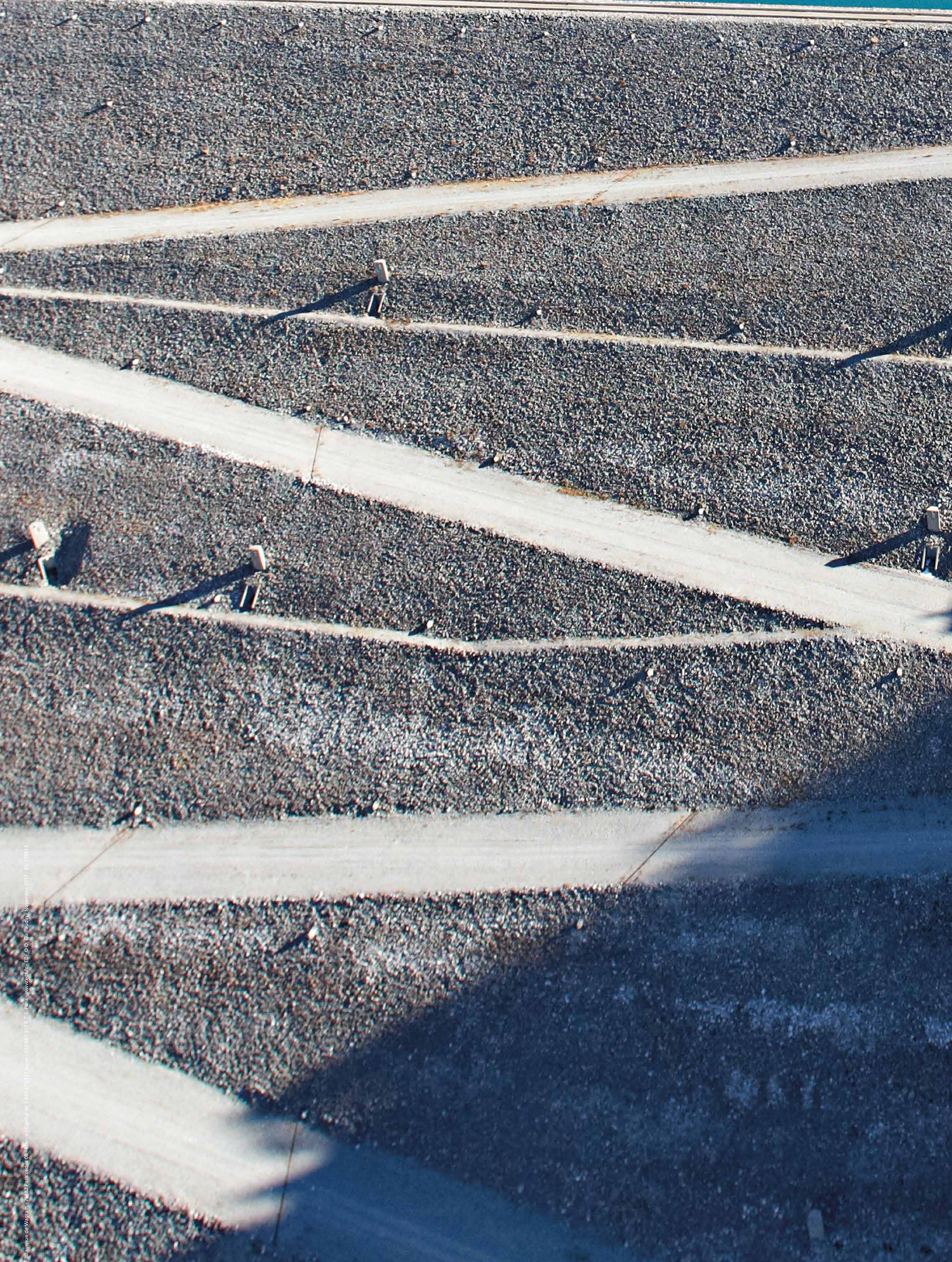
BARRAGE DE GRAND'MAISON
